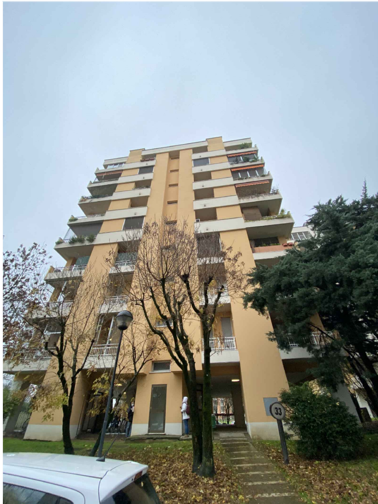
Foto prospetto lato nord
