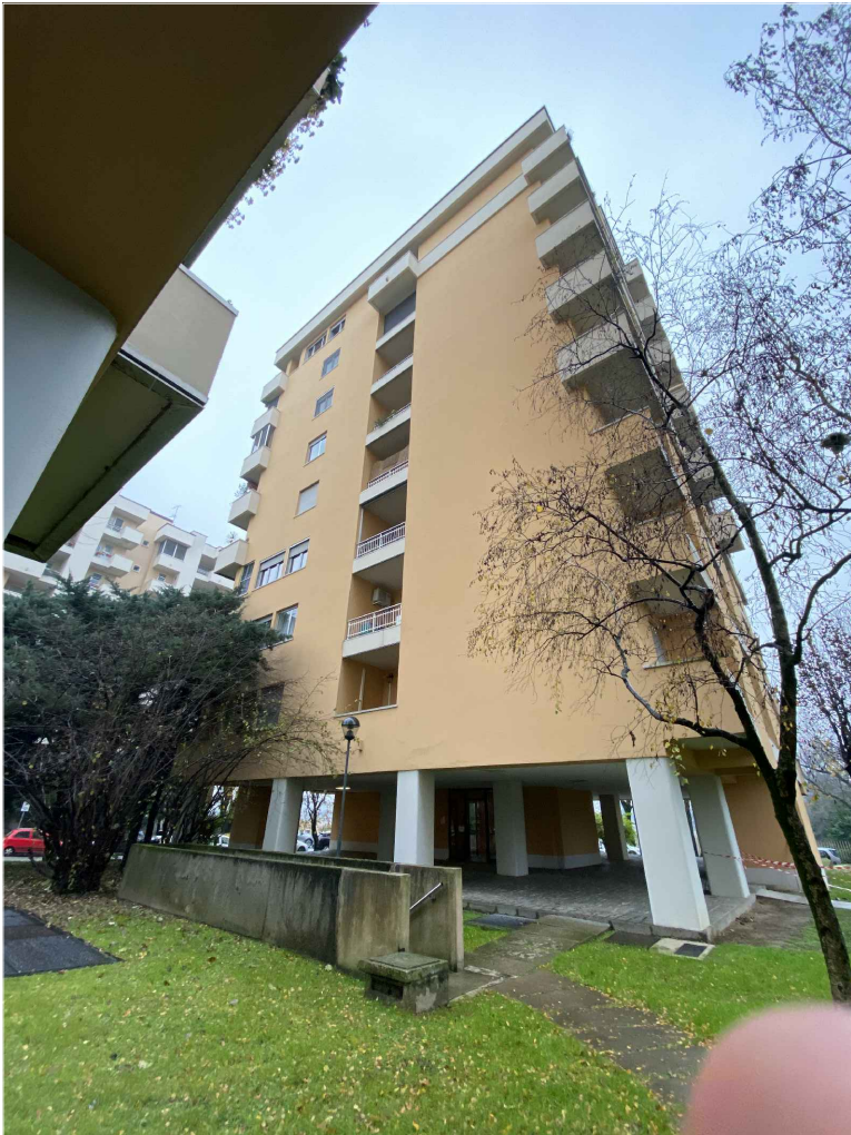
Foto prospetto lato ovest
